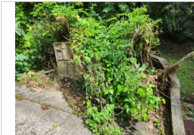
Aplatissement végétation et dépôt matière solide liée à la sortie de son lit de la ravine salée
