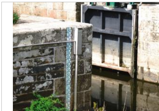
Echelle aval de l'écluse de Rieux à Saint-Congard
