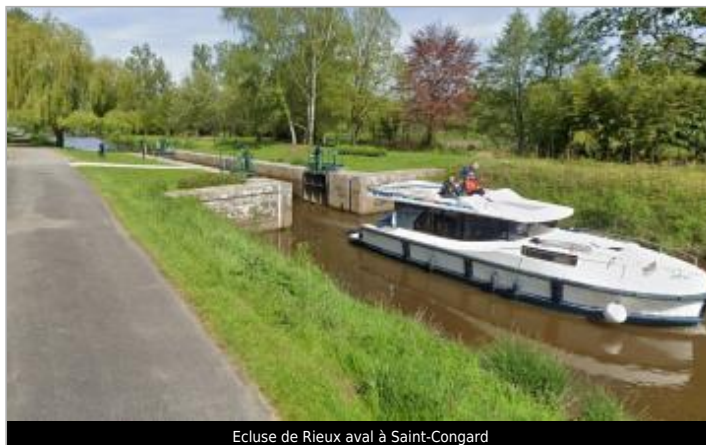
Ecluse de Rieux aval à Saint-Congard
