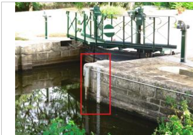
Ecluse de Rieux amont à Saint-Congard
