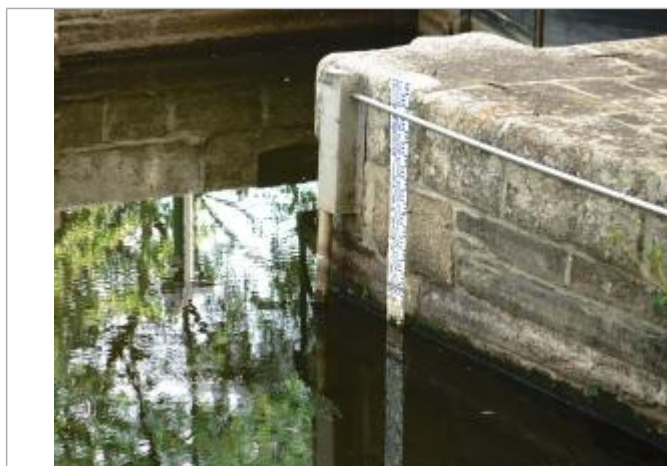
Echelle amont de l'écluse de Rieux à Saint-Congard
