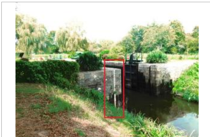
Aval de l'écluse de Beaumont à Saint-Congard
