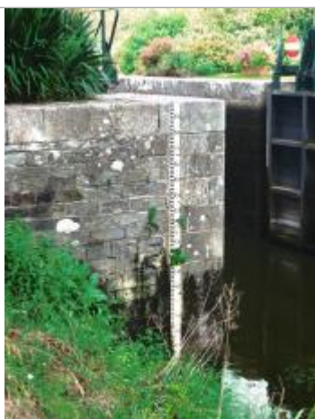
Echelle aval de l'écluse de Beaumont à Saint-Congard
