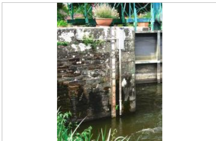
Echelle aval de l'écluse de Foveno à Saint-Congard
