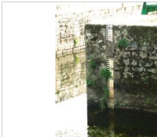
Echelle amont de l'écluse de la Née à Saint-Marcel
