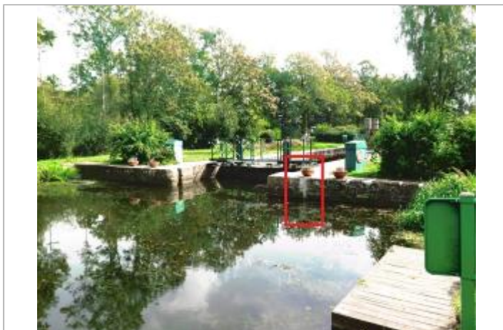
Ecluse de la Née (Métairie) amont à Saint-Marcel
