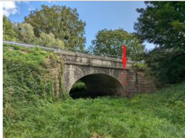
Vue du site coté aval du pont.
