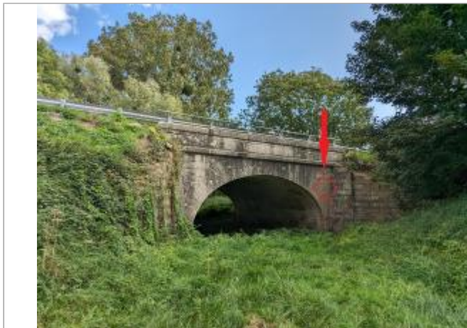
Vue du site coté aval du pont.
