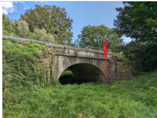
Vue du site côté aval du pont.
