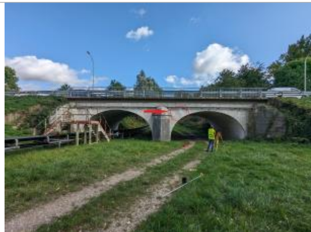
Vue du pont, en bas depuis le coté aval.
