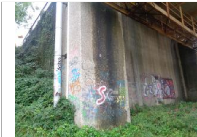
Vue du pilier du pont depuis chemin de halage.
