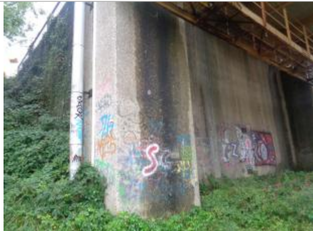
Vue du pilier du pont depuis chemin de halage.
