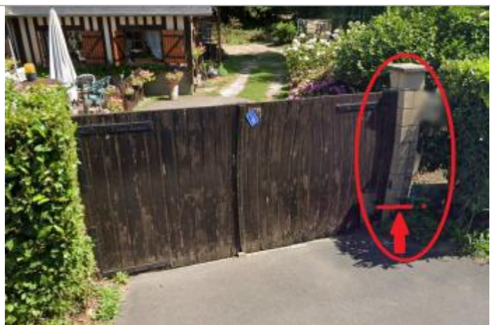
Laisse de crue à 38 cm/sol
