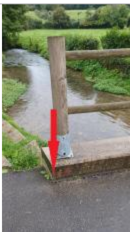
Vue du repère à 15 cm/sol
