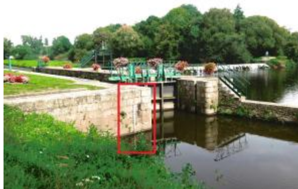
Ecluse de la Ville aux Fruglins aval au Val d'Oust
