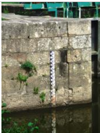
Ecluse aval de la Ville aux Fruglins au Val d'Oust
