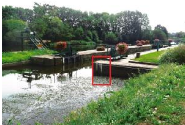
Ecluse de la Ville aux Fruglins amont au Val d'Oust
