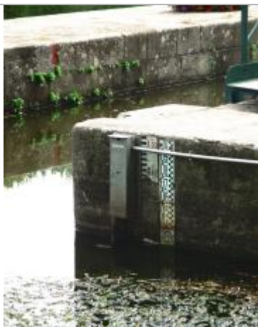
Ecluse amont de la Ville aux Fruglins au Val d'Oust
