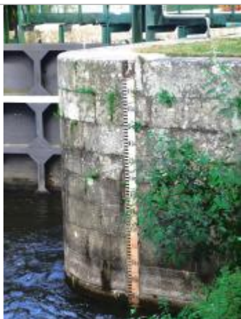
Echelle aval de l'écluse de Montertelot
