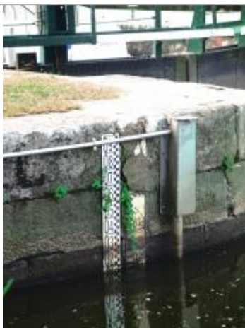
Echelle amont de l'écluse de Montertelot
