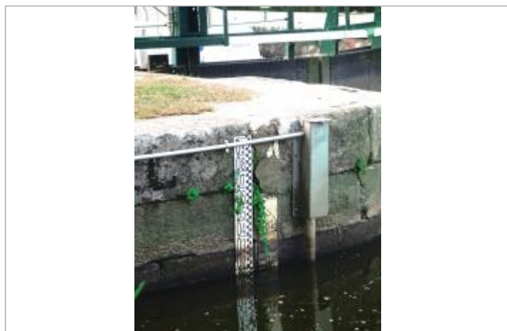
Echelle amont de l'écluse de Montertelot
