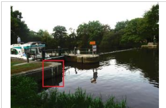
Ecluse de Montertelot amont
