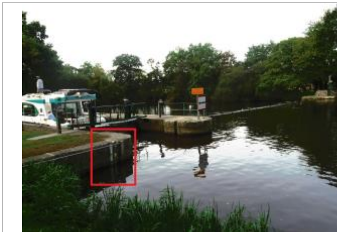
Ecluse de Montertelot amont
