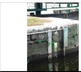
Echelle amont de l'écluse de Montertelot
