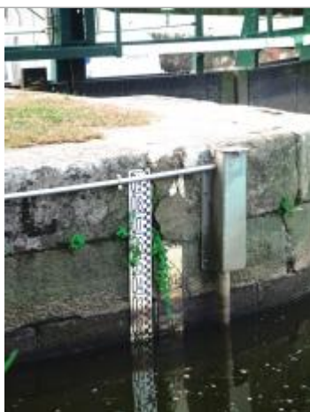
Echelle amont de l'écluse de Montertelot
