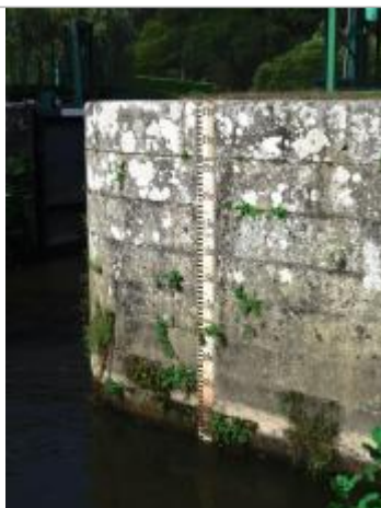
Echelle aval de l'écluse de Blon à Guillac
