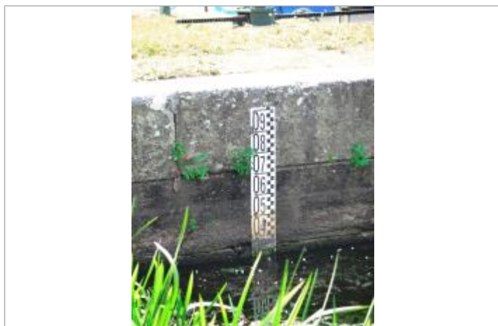
Echelle amont de l'écluse de Blon à Guillac
