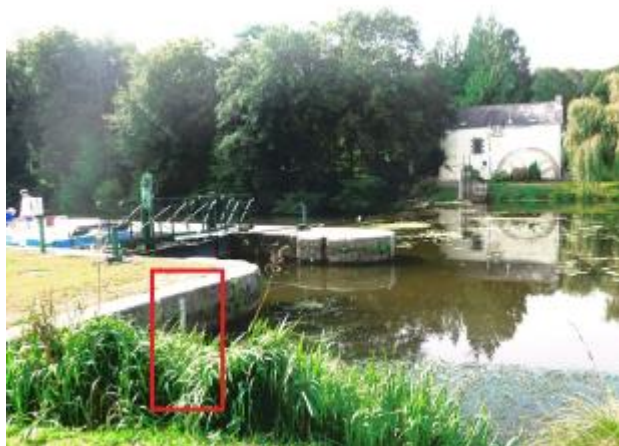
Echelle amont de l'écluse de Blon à Guillac
