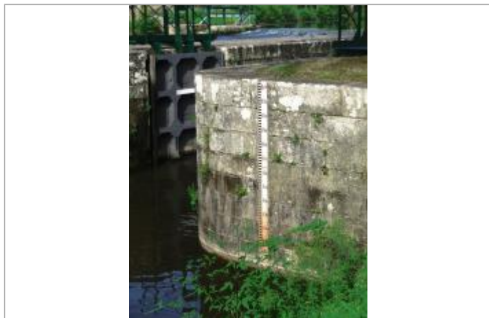
Echelle aval de l'écluse de Guillac
