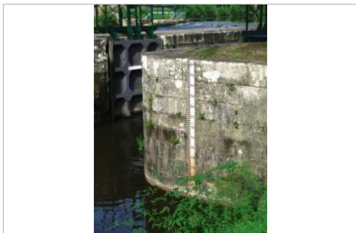
Echelle aval de l'écluse de Guillac
