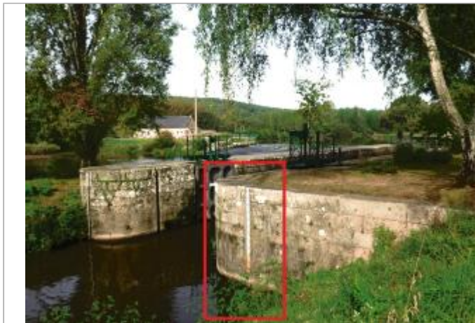
Ecluse de Guillac aval
