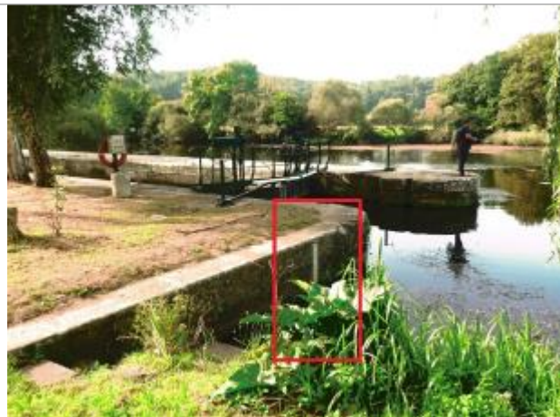
Ecluse de Guillac amont
