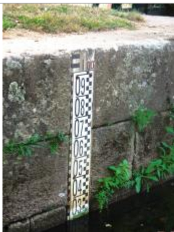
Echelle amont de l'écluse de Guillac
