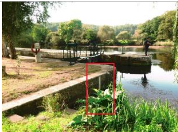
Ecluse de Guillac amont
