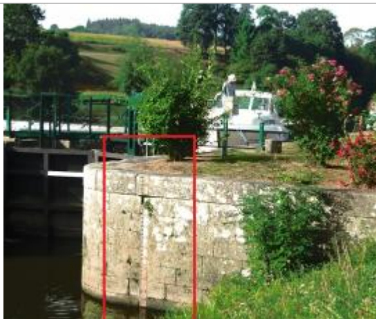
Ecluse de Carmenais aval à Guillac
