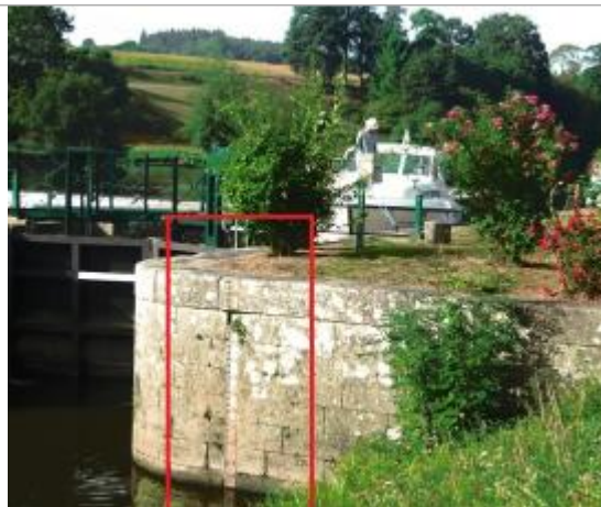
Ecluse de Carmenais aval à Guillac
