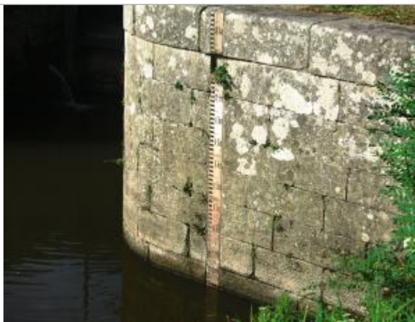
Echelle aval de l'écluse de Carmenais à Guillac
