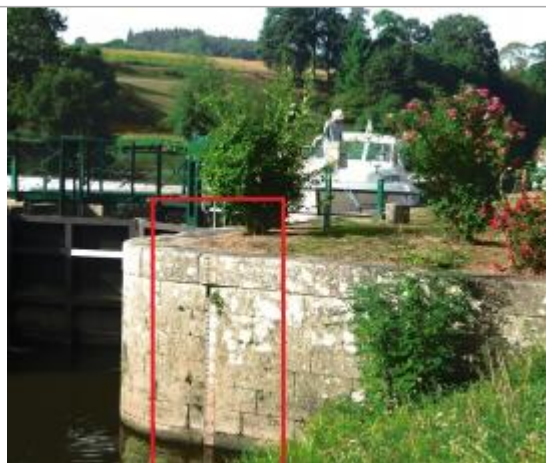
Ecluse de Carmenais aval à Guillac
