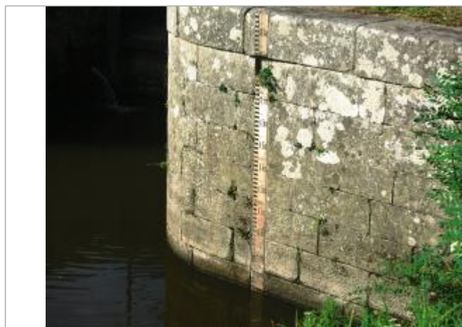
Echelle aval de l'écluse de Carmenais à Guillac
