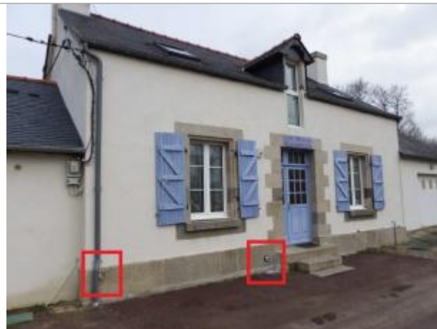
Maison éclusière de Carmenais à Guillac
