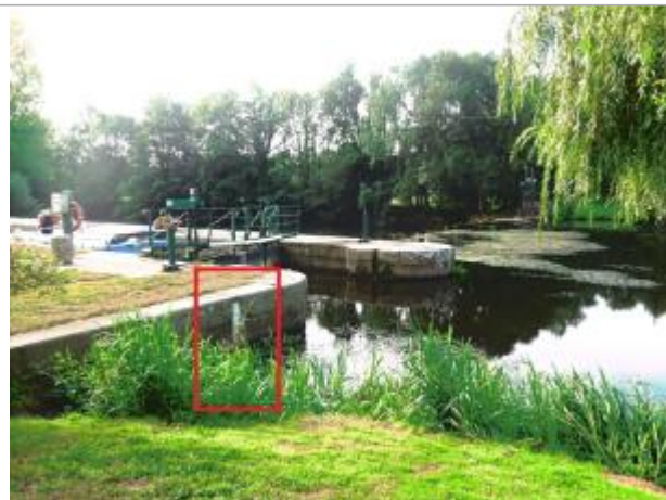
Ecluse de Clan amont à Guillac
