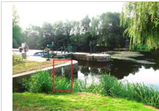
Ecluse de Clan amont à Guillac
