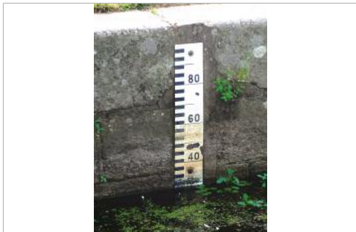
Echelle amont de l'écluse de Clan à Guillac
