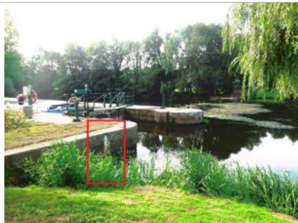
Ecluse de Clan amont à Guillac
