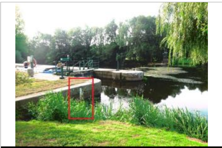
Ecluse de Clan amont à Guillac
