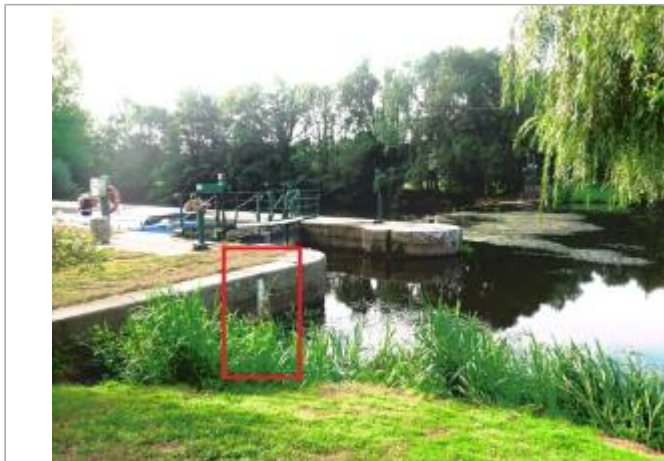
Ecluse de Clan amont à Guillac
