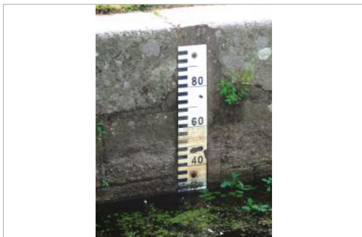
Echelle amont de l'écluse de Clan à Guillac
