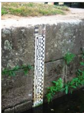
Echelle aval de l'écluse de Clan amont à Guillac
