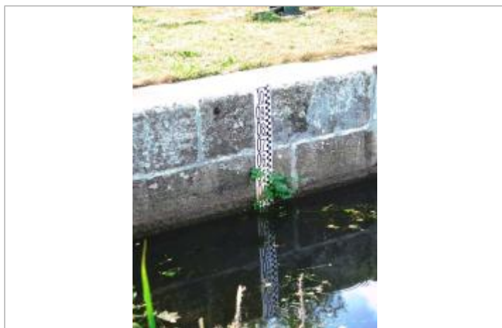
Echelle amont d'écluse de Saint Jouan à Guillac
