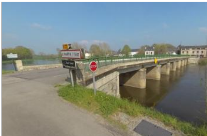
Pont du Gueslin de la RD 777 à Saint-Martin-sur-Oust
