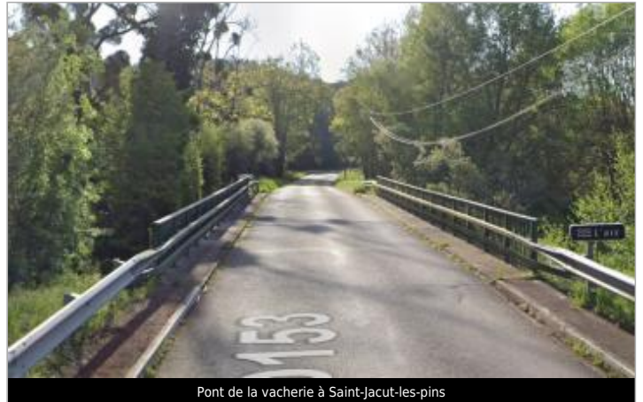
Pont de la vacherie à Saint-Jacut-les-pins
