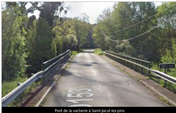
Pont de la vacherie à Saint-Jacut-les-pins
