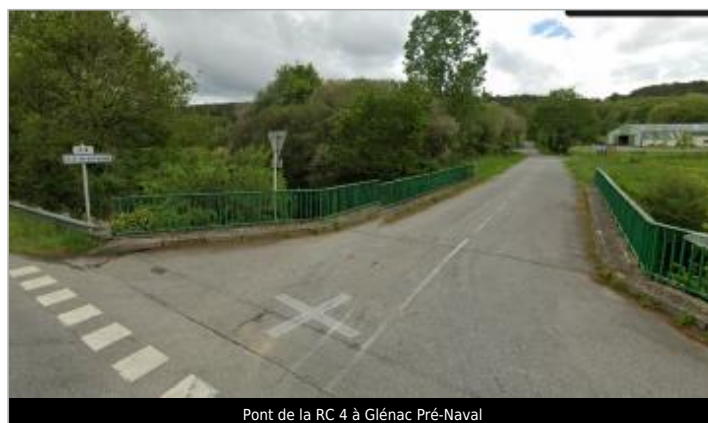
Pont de la RC 4 à Glénac Pré-Naval
