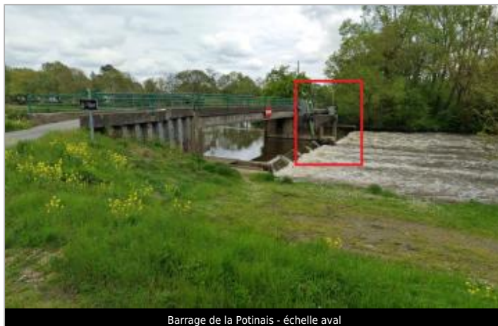
Barrage de la Potinais - échelle aval
