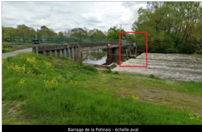
Barrage de la Potinais - échelle aval
