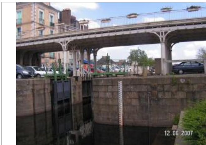
Station Vigicrues du canal de Nantes à Brest à Redon
