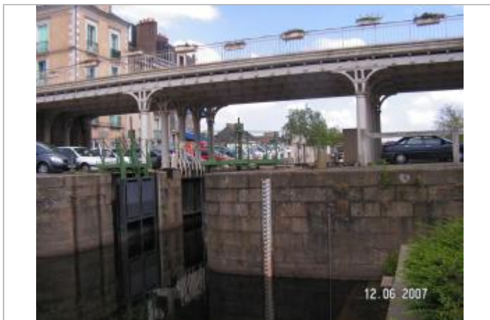
Station Vigicrues du canal de Nantes à Brest à Redon
