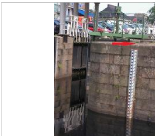
Echelle limnimétrique de la station Vigicrues
