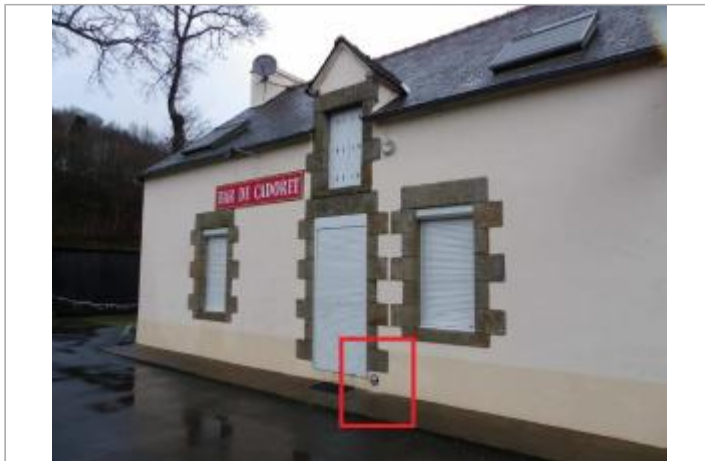
Maison au lieu-dit "Cadoret" (ancien commerce)
