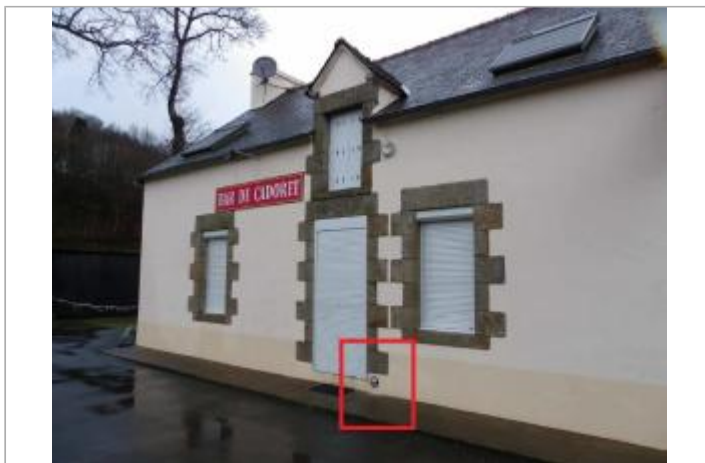
Maison au lieu-dit "Cadoret" (ancien commerce)
