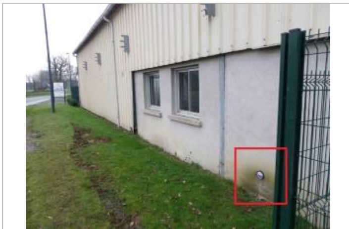
Centre d'incendie et de secours
