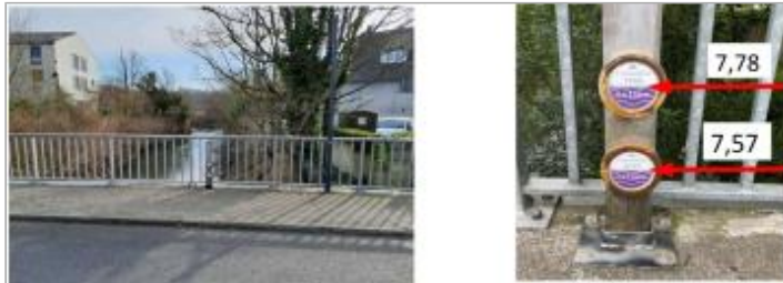
Ouvrage d'art Support: Poteau bois 20 rue de la gare
