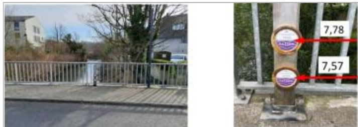
Ouvrage d'art Support: Poteau bois 20 rue de la gare
