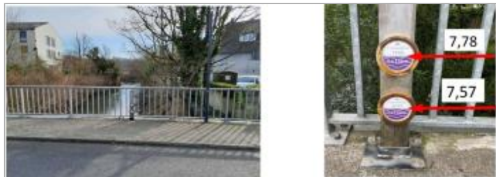
Ouvrage d'art Support: Poteau bois 20 rue de la gare 2019
