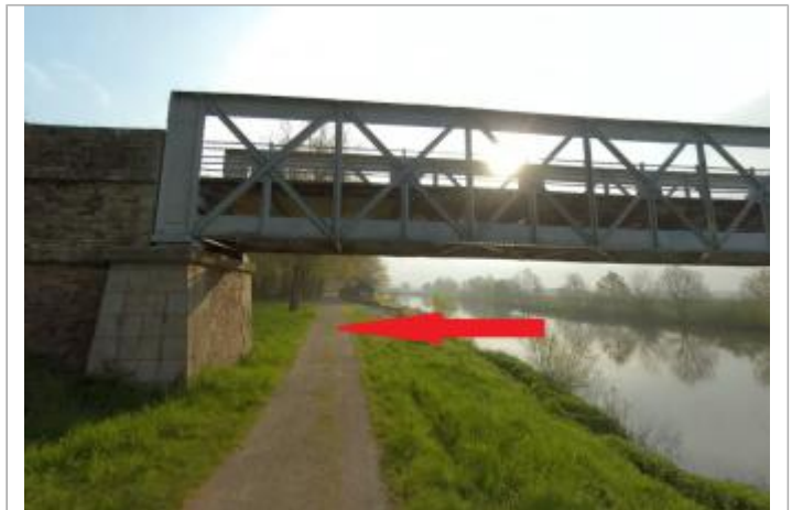
Sous le pont de l'ilette RD125 sur la Vilaine
