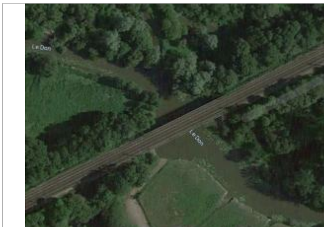
Pont de la voie ferrée sur le DON
