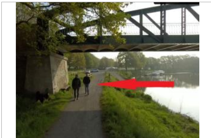
Sous le viaduc du Grand Pas
