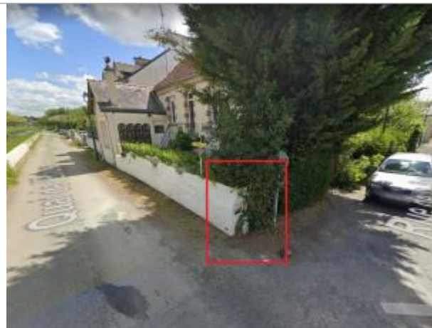
Muret à l'angle du quai de l'écluse et de la rue de la Batellerie
